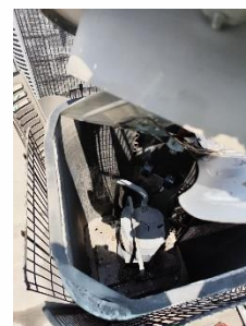
Unidad condensadora durante el mantenimiento
