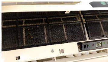
Unidad evaporadora durante el mantenimiento
