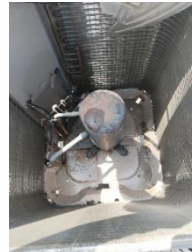
Unidad condensadora durante el mantenimiento
