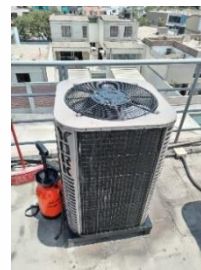
Unidad condensadora durante el mantenimiento
