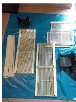
Filtros de aire y serpentín de evaporación durante el mantenimiento
