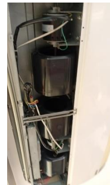
Unidad evaporadora durante el mantenimiento
