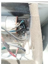
Unidad condensadora antes del mantenimiento
