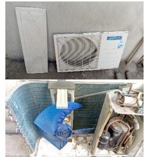
Unidad condensadora durante el mantenimiento
