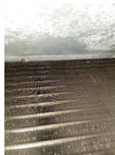
Serpentín de la unidad evaporadora durante el mantenimiento
