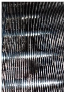
Filtros de aire y serpentín de evaporación durante el mantenimiento
