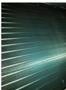
Serpentín de la unidad evaporadora después del mantenimiento
