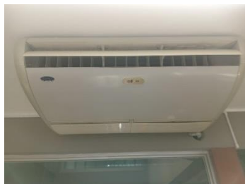
Unidad evaporadora antes del mantenimiento
