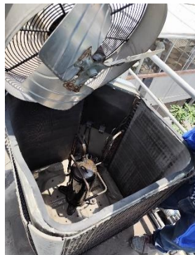
Unidad condensadora antes del mantenimiento
