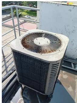
Unidad condensadora después del mantenimiento
