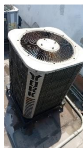
Unidad condensadora después del mantenimiento
