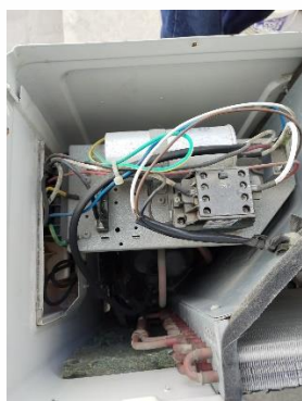
Unidad condensadora durante el mantenimiento
