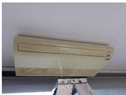
Unidad evaporadora durante el mantenimiento
