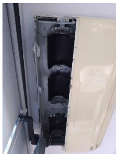
Unidad evaporadora durante el mantenimiento
