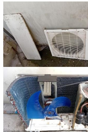
Unidad condensadora después del mantenimiento
