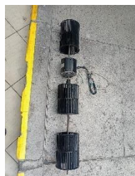
Motor de la unidad evaporadora después del mantenimiento
