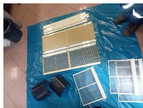
Filtros de aire después del mantenimiento
