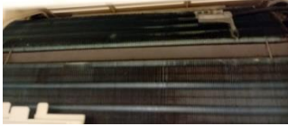
Unidad evaporadora antes del mantenimiento
