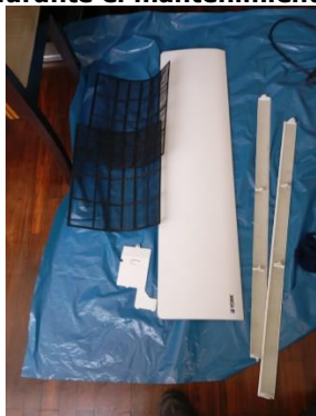
Filtros de aire después del mantenimiento
