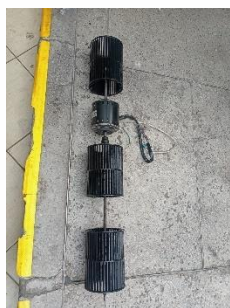
Motor de la unidad evaporadora durante el mantenimiento
