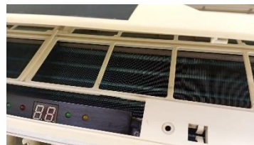
Unidad evaporadora durante el mantenimiento
