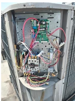
Unidad condensadora durante el mantenimiento
