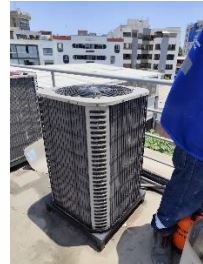
Unidad condensadora después del mantenimiento
